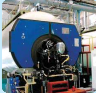
3-Pass 노통연관식 보일러 FIRE TUBE TYPE BOILER
